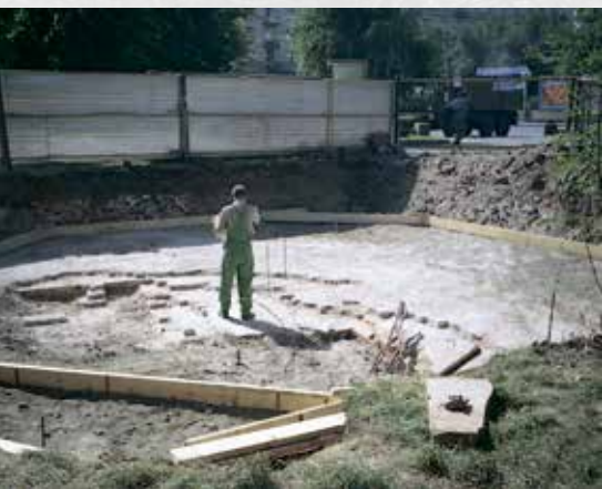
Решение о привязке часовни было непростым: за спиной строителя непрочный участок подвала собора, заполненного кирпичной крошкой
