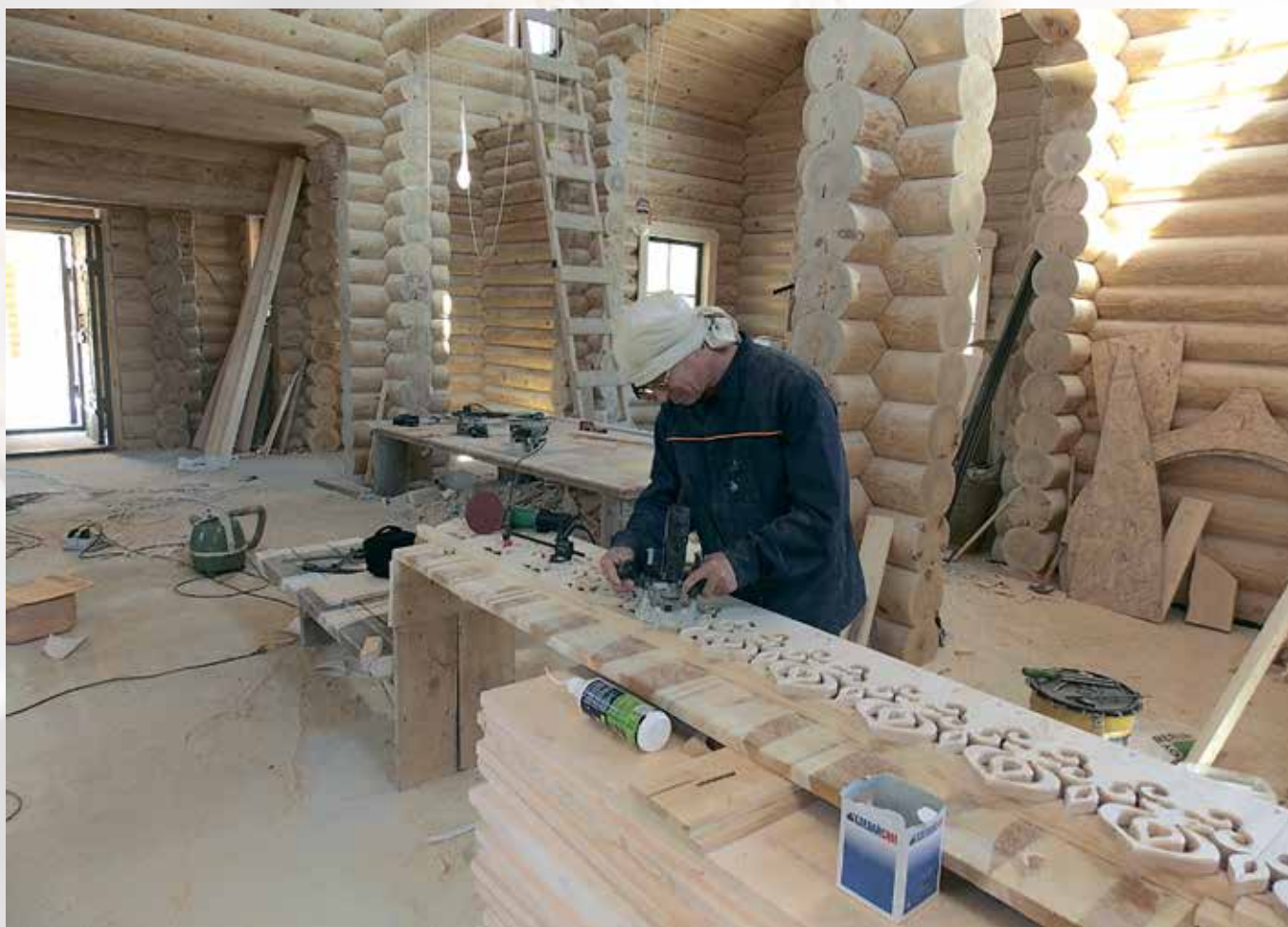
Мастер за работой. Изготавливает домовые резьбы, причелины
