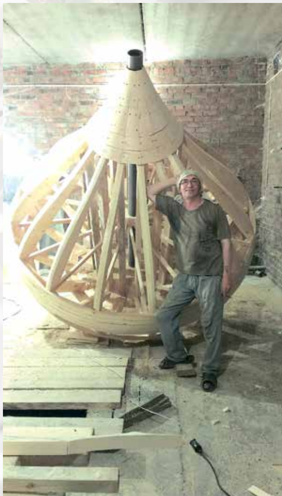
Тихорецк. Главка для деревянного храма почти готова
