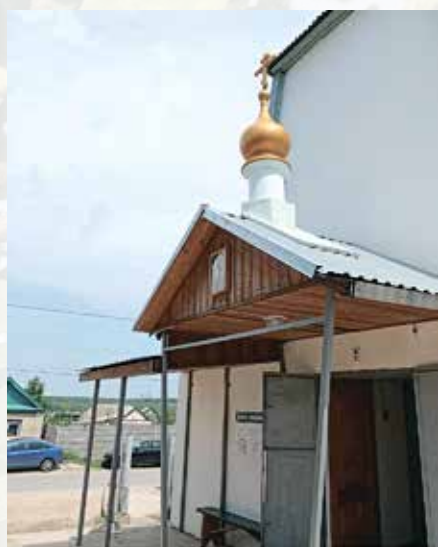
Первая входная дверь ведет в храм «футляр», возведенный для сохранности внутреннего деревянного храма, построенного жителями освобожденного Сталинграда в 1943 году буквально на пепелищах
