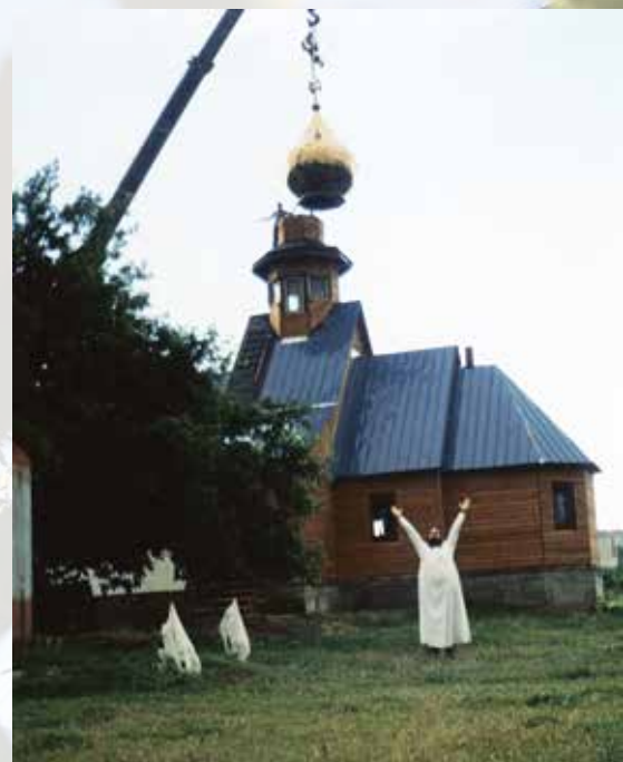
Установка купола на новый храм
