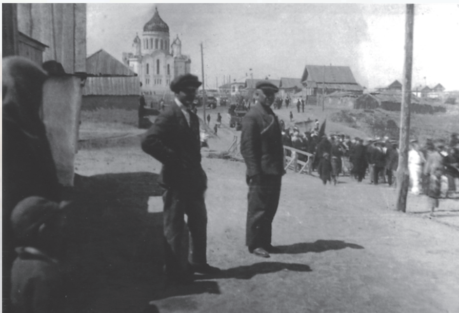
В 1905 году было начато строительство большого каменного храма, освященного в 1914 году. На старинном фото узнать наш храм в его нынешнем состоянии совершенно невозможно
