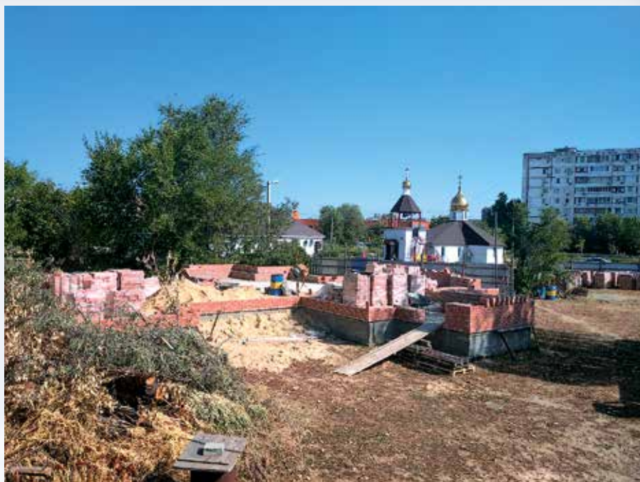
Кирпич для возведения стен храма завезен
