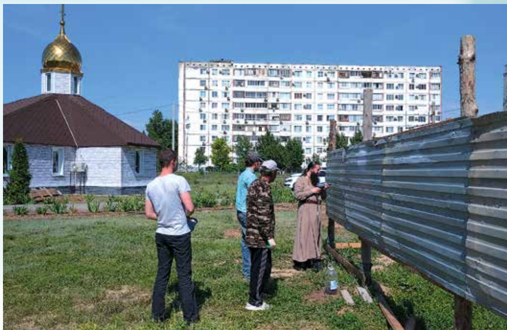
Отец Даниил монтирует ограждение стройплощадки
