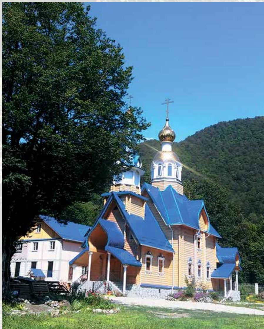
Строительство нового храма в честь Усекновения главы пророка, Предтечи и Крестителя Господня Иоанна стало возможным благодаря молитвам старца схиархимандрита Ионы (Игнатенко), трудам монахов-пустынников и самой общины при поддержке благодетелей
