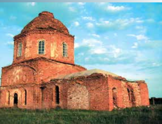
Храм в самом начале восстановительных работ: усердием прихода уже поставлены окна. Фото 2000 года
