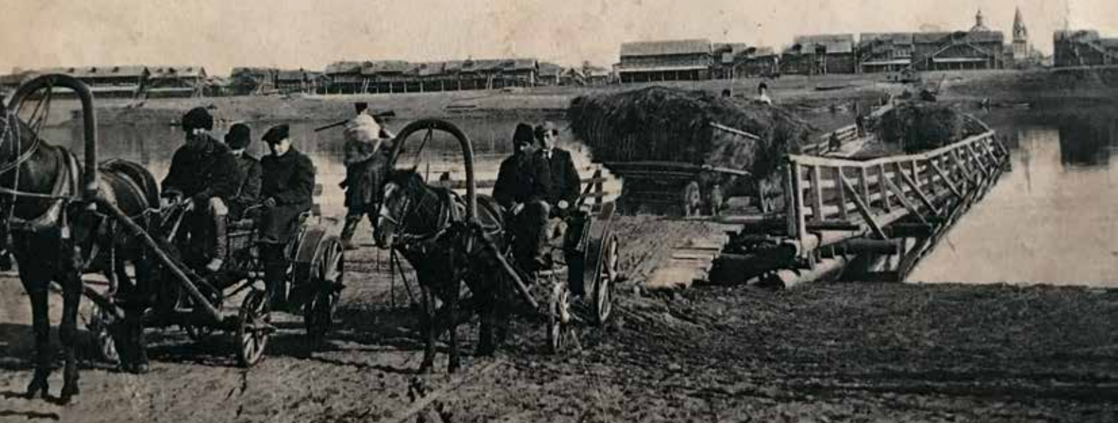
Переезд через мост из слободы Николаевской в Камышин. Источник http://www.фотостарина.рф/file/kamyshin/Kamyshin_Pereezd_cherez_most_iz_slobody_Nikolaevskoi_v_Kamyshin..jpg
