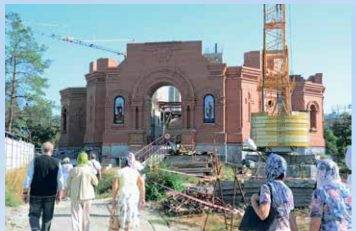
12 сентября 2017 год. Прихожане спешат на первую в строящемся соборе литургию
